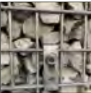
Armatura in acciaio
