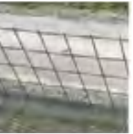
Cassero in rete elettrosaldata
