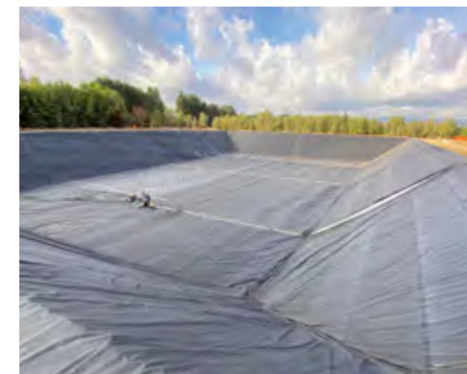
Bacino di accumulo in EPDM
