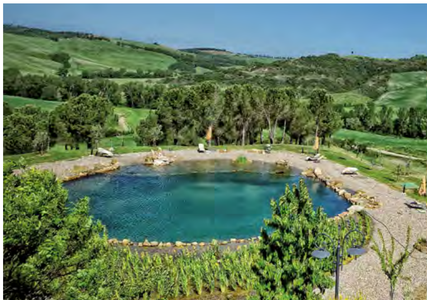
Bacino di accumulo in EPDM
