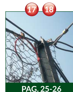
Barriere paramassi Barriere fermaneve
