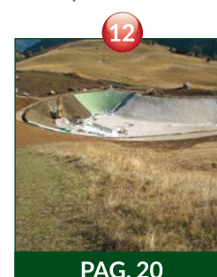
Bacini di accumulo idrico
