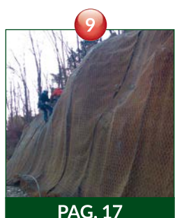
Protezione dalla caduta di sassi
