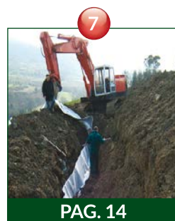
Drenaggi con geocompositi
