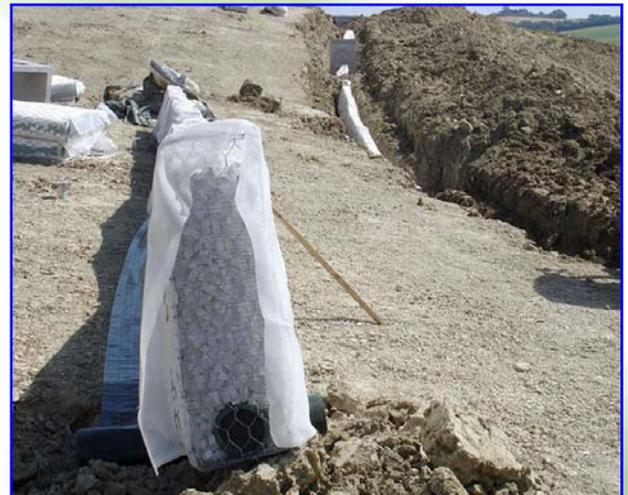
**Foto 1** – Pannello drenante Gabbiodren®T nella bonifica di un versante per la realizzazione di un campo fotovoltaico
