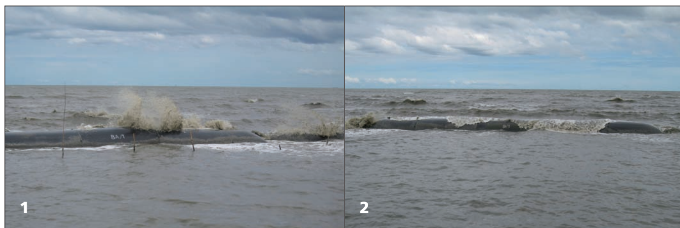
Figure 1 e 2: geotessili tubolari SoilTain® affioranti temporaneamente dall'acqua per la bassa marea ed utilizzati come frangiflutti sotto l'azione dell'onda
