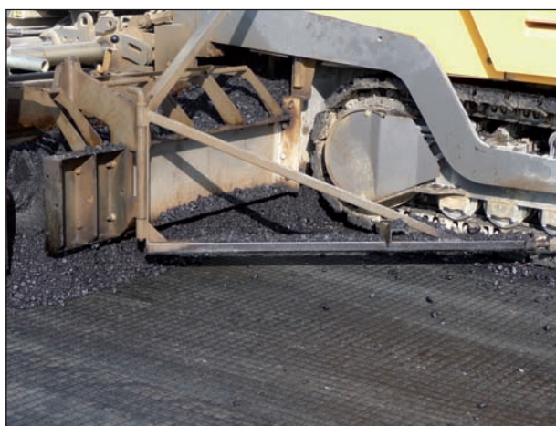
Posa dell'asfalto con finitrice
