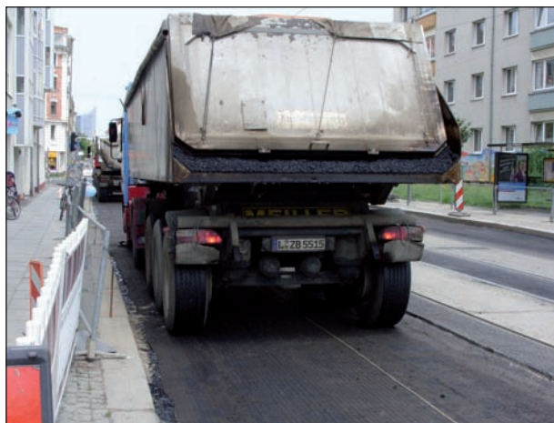
Transito dei mezzi da cantiere sul SamiGrid®
