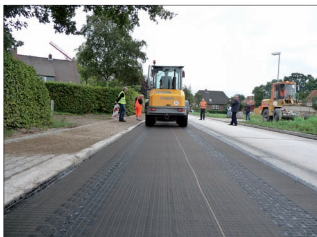
Materiale aderente al piano di posa
