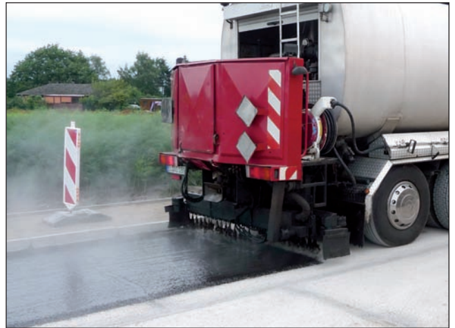
Spruzzatura dell'emulsione bituminosa
