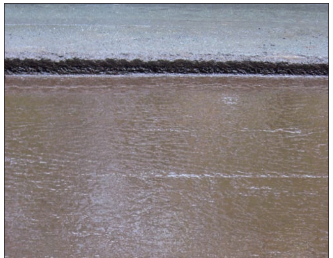
Emulsione bituminosa appena spruzzata
