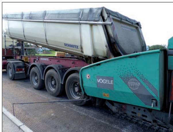
Camion che alimenta la finitrice
