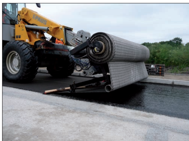
Posa con l'ausilio di macchinari
