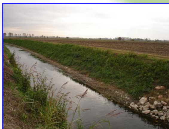
Foto 3 – La foto illustra la situazione del canale a sette mesi dalla realizzazione dell'intervento. La tipologia di geocomposito utilizzata antinutria/antigambero è in rete metallica in maglia 6x8 filo 2.20/3.20 ZN.AL e plasticata preaccoppiata con georete tessuta in PET ad alta tenacità (maglia 3x3mm)
