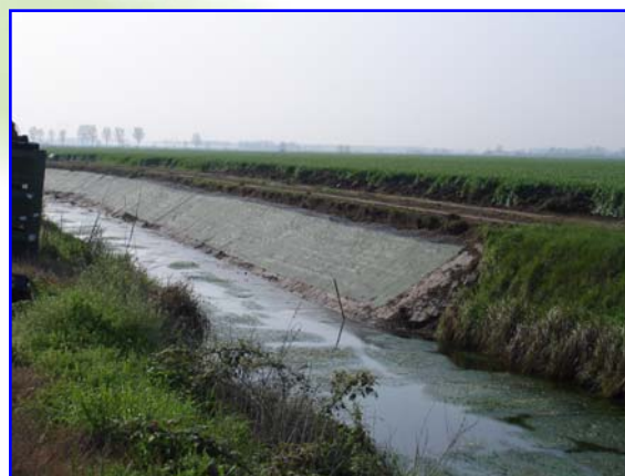
Foto 2 – Intervento di consolidamento e protezione antinutria/antigambero su Canale Molinella, MN (per gentile concessione Consorzio Bonifica Fossa Di Pozzolo – Mantova, Direttore Dott. Agr. Cesare Bozzacchi, Capo Area Tecnico Ing. Oliviero Zucchini)
