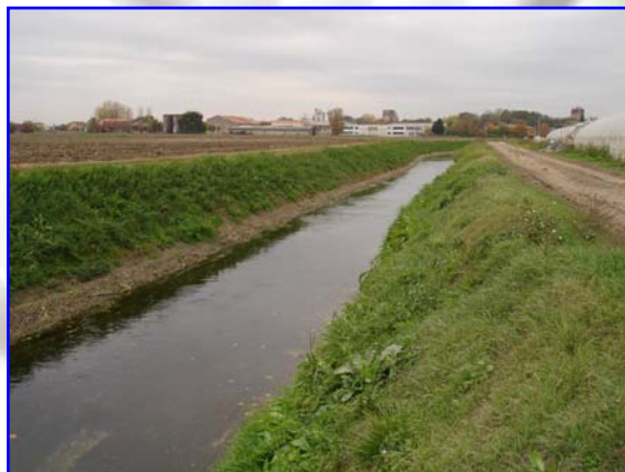
Foto 5 – Situazione del canale prima e dopo l'intervento
