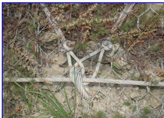
Foto 6 – Dettaglio dell'ancoraggio al piede del sistema paramassi
