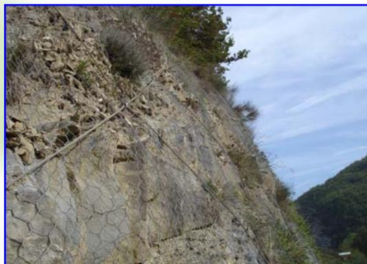
*Foto 2 – Dettaglio di un intervento in parete realizzato con rete paramassi, chiodatura e tirantatura con funi in trefoli in acciaio*
