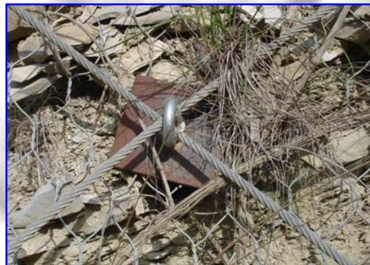
*Foto 4 – Dettaglio della testa dell'ancoraggi, della piastra e del golfaro passacavo*
