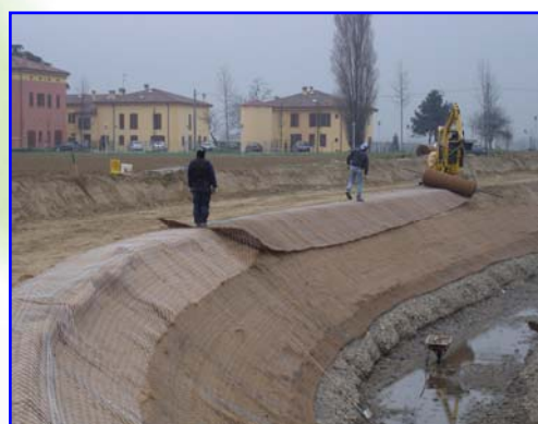
Foto 6 – Realizzazione dei materassi e stesa del geocomposito
