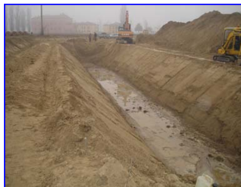
Foto 5 – Interventi tipo schema fig.1 – inizio lavori
