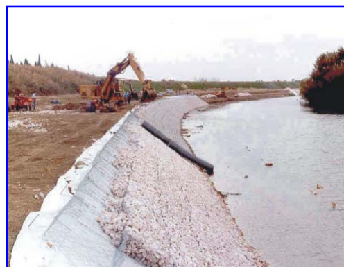
Foto 1 – Fasi di posa di un rivestimento in Materassi
