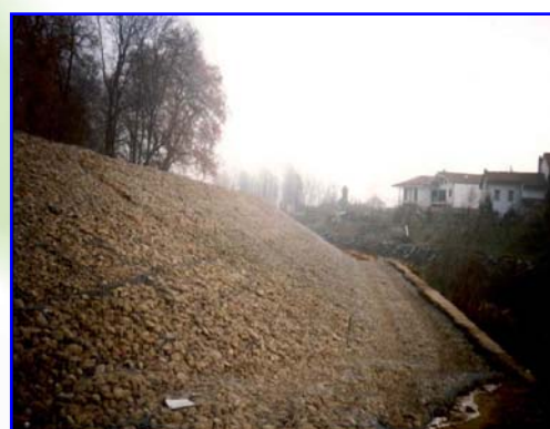
Foto 2 – Rivestimento spondale in Materassi, fine lavori
