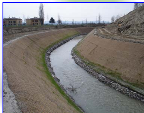
Foto 7 – Situazione a fine lavori
