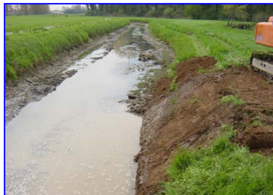
Foto 1 – Fasi di posa in opera, riprofilatura della sponda
