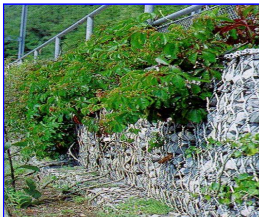
Foto 1 – Muro di sottoscarpa in gabbioni
