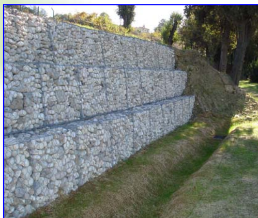
Foto 2 – Muro di controripa in gabbioni
