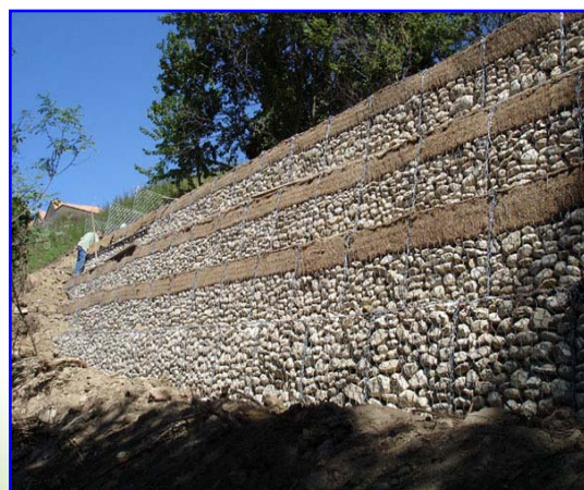
Foto 2 – La foto mostra le ultime fasi di costruzione del muro di sostegno in Gabbioni Verdi e riempimento delle tasche vegetative
