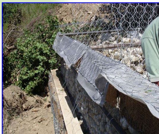
Foto 3 – Il dettaglio permette di apprezzare il posizionamento delle tasche vegetative chiuse, prima della messa in forma, legatura e riempimento con terreno vegetale
