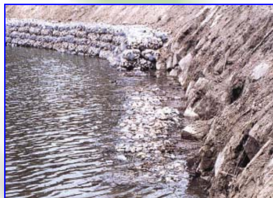
Foto 2 – Intervento di consolidamento di sponda con gabbioni cilindrici
