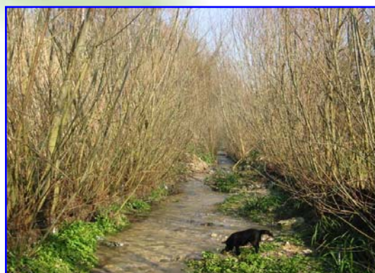
Foto 4 – Intervento di consolidamento al piede di una sponda con opere di Ingegneria Naturalistica in gabbioni cilindrici e talee di salice
