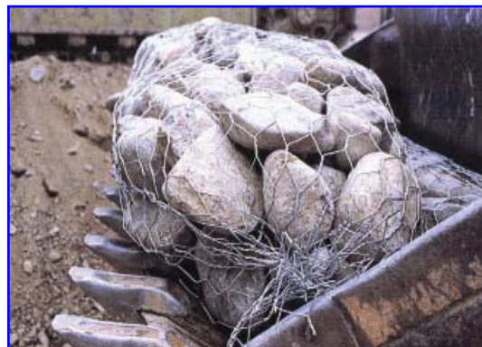
Foto 1 – Realizzazione di una burga e alloggiamento sul cucchiaio benna per posa in opera
