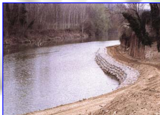
Foto 3 – Realizzazione di intervento di protezione idraulica di sponda con gabbioni cilindrici
