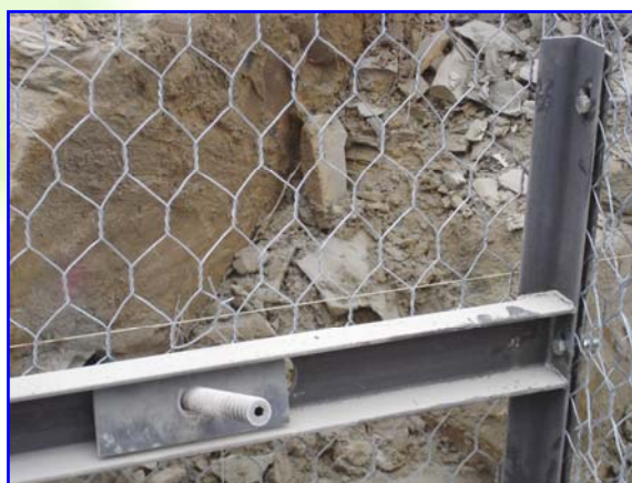
Foto 2 – Dettaglio della piastra e testa del chiodo
