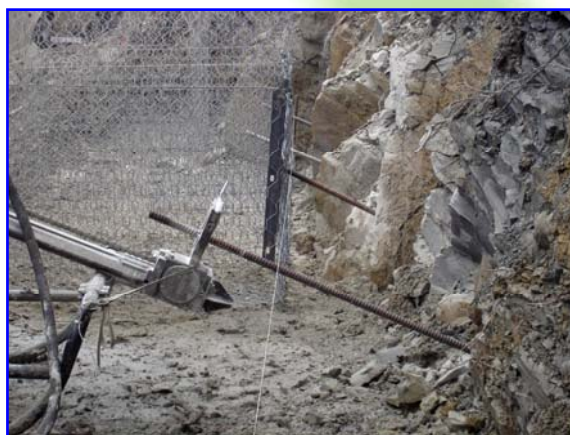
Foto 3 – Realizzazione della chiodature
