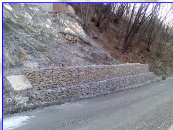
Foto 4 – Gabbionata chiodata a fine lavori
