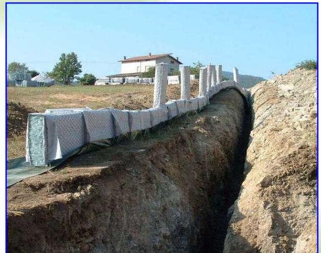
Foto 2 – Trincea assemblata con pannelli Gabbiodren® pronta per essere calata nella trincea di scavo a sezione obbligata
