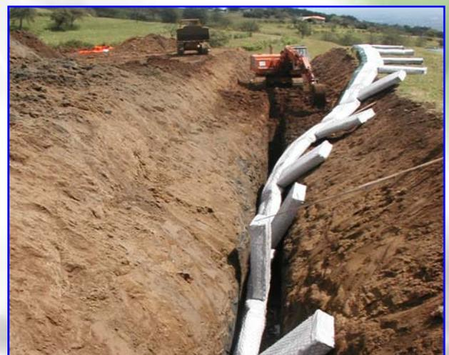
Foto 3 – Avanzamento dello scavo e contestuale posa della linea drenante assemblata in sicurezza immediatamente a fianco della trincea
