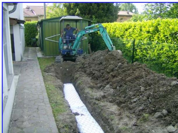
**Foto 4** – Il pannello Gabbiodren® viene utilizzato per realizzare in modo sicuro e rapido drenaggi per la bonifica in campo edilizio dove esistono esigui spazi di lavoro
