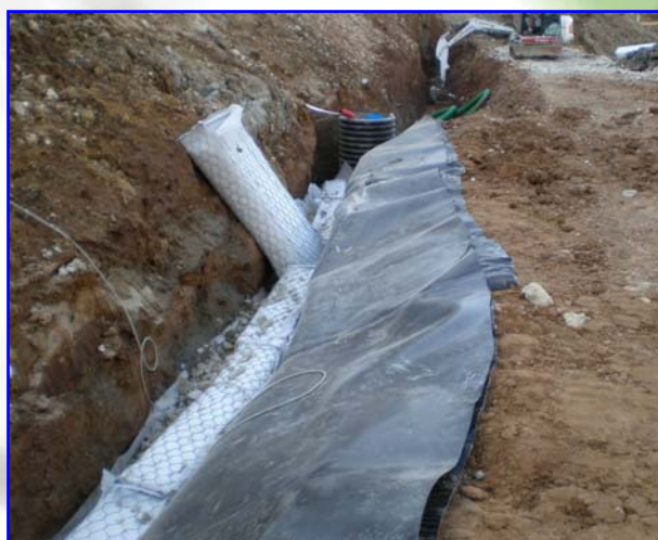
Foto 3 – Applicazione dei Pannelli drenanti Gabbiodren® tipo FORTE nel drenaggio di percolati particolarmente aggressivi al piede di una discarica di accumulo di fanghi inquinanti
