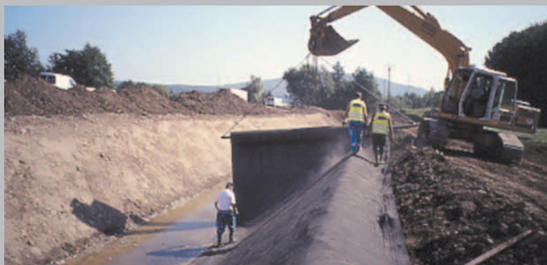
Letto di un canale rivestito con NaBento®
