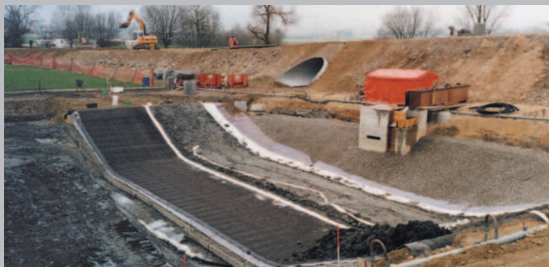
Impermeabilizzazione del fondo di una discarica con il NaBento®
