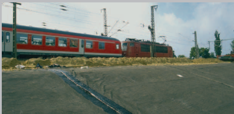
Impermeabilizzazione lungo i tracciati ferroviari
