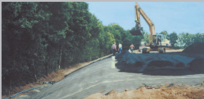
Impermeabilizzazione della copertura di una discarica con il NaBento®
