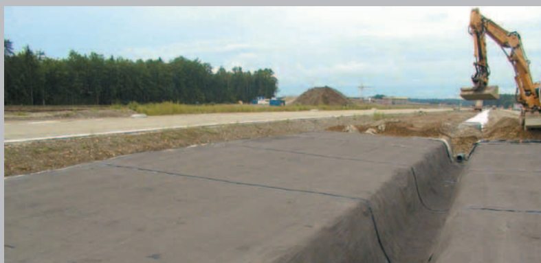
Protezione dell'acqua di falda situata nelle adiacenze di una strada
