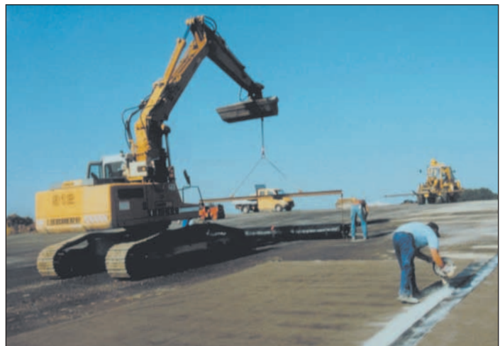
Installazione del NaBento® in una discarica
