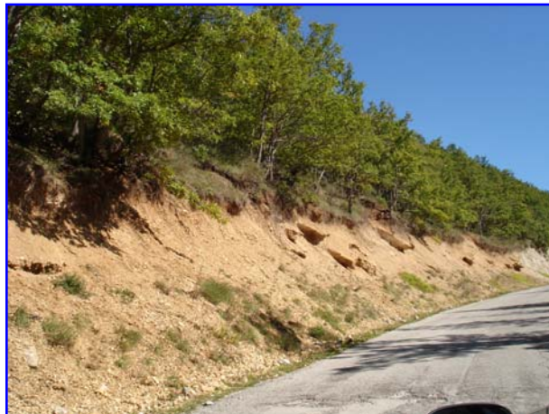
Scarpata stradale in roccia tenera soggetta a fenomeno di perdita di suolo. Una adeguata protezione antierosiva può fermare l'arretramento e innescare un progressivo rinverdimento.
