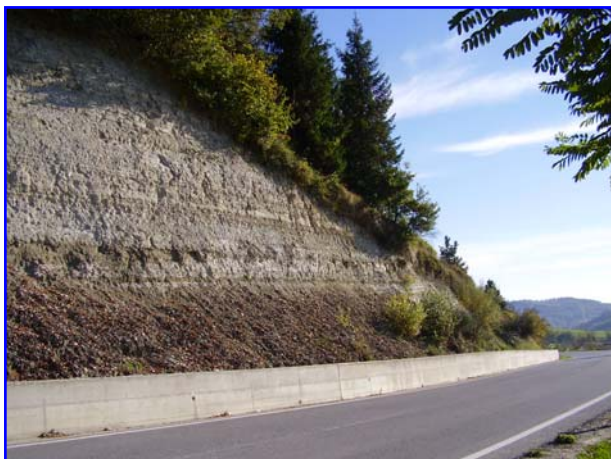
Scarpata di neoformazione per la realizzazione di una strada. Se non adeguatamente protetta sarà soggetta ad arretramento per degradazione da parte di fenomeni esoqeni e a possibile colamento di detrito.
