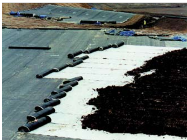
Posa in orizzontale
