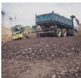
Rinforzo di base
