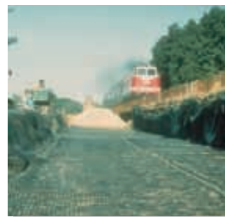
Rilevati su pali
