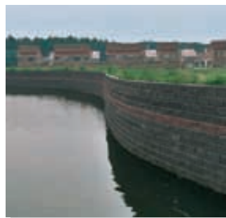
Muri in blocchi rinforzati
