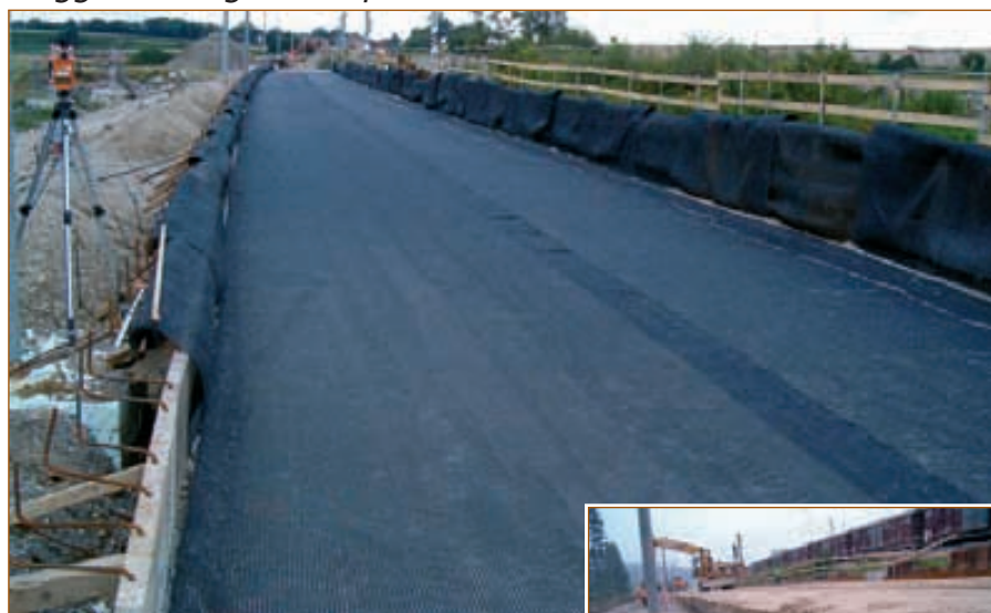
Rilevato ferroviario su pali, Augsburg-Olching
