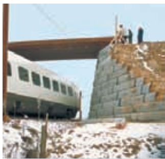
Spalle da ponte
