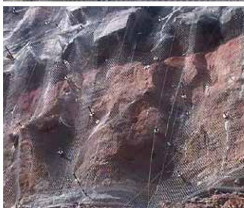
Il filo impiegato per la rete **3STutor®Plus** viene prodotto appositamente e garantisce una maggior resistenza alla corrosione, avendo un rivestimento di Zinco-Alluminio in classe A o, su richiesta, superiore.
