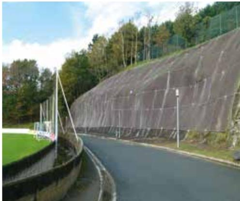
Il **Sistema 3STutor®Plus** è un innovativo sistema flessibile per la stabilizzazione e per il consolidamento passivo di versanti.
