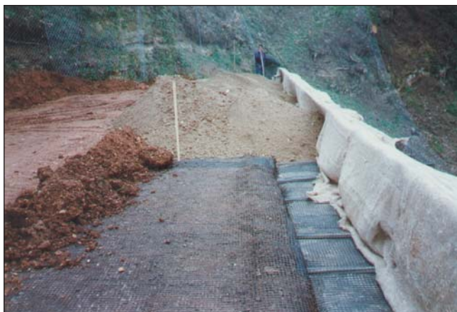
Biocover sul paramento di una terra rinforzata
