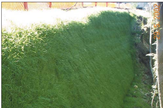
Paramento rinverdito di una terra rinforzata
