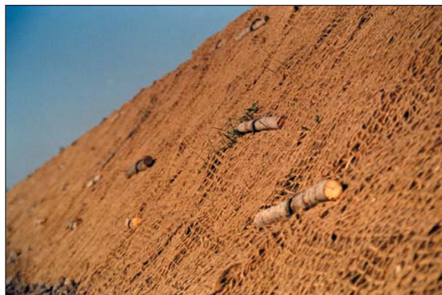
Particolare del fissaggio con picchetti ad "U" e paletti
