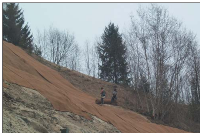
Fase di posa del Bionet
