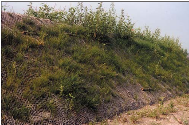
Biorete in juta Bionet HJ/50 (Muzzana - UD)
