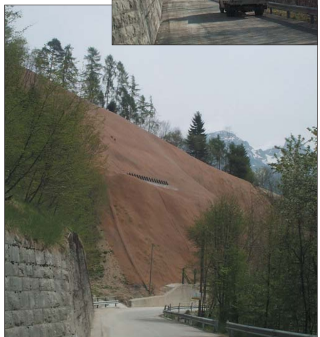
Biorete in cocco Bionet HC/70 (Puos d'Alpago - BL)
