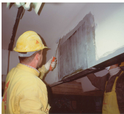
Stesa di un nuovo strato di resina per l'intasamento del tessuto.
