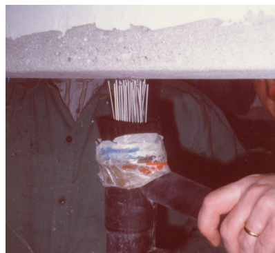
Bocciardatura con pistola ad aghi.
