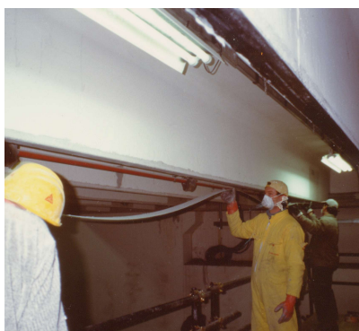
Applicazione della lamina in fibra di carbonio.
