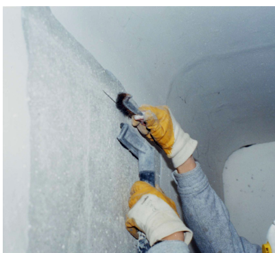
Spazzolatura e aspirazione della polvere nella zona appena bocciardata.
