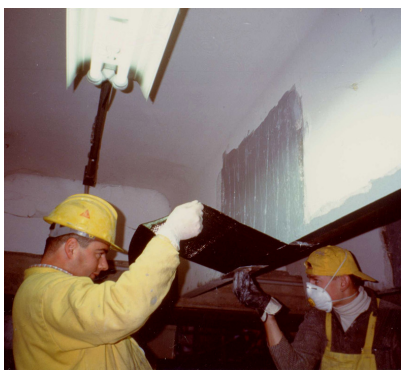
Stesa della resina epossidica e del tessuto in fibra di carbonio.
