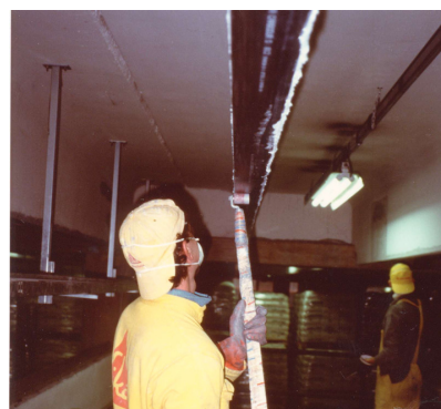
Rullatura della lamina per far defluire la resina in eccesso e sua eliminazione.
