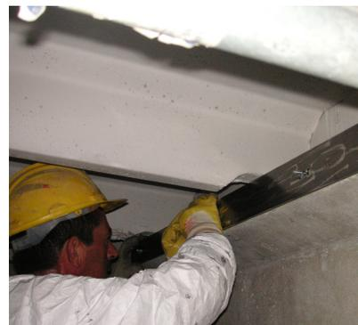
Posizionamento della lamina d'acciaio sul fianco superiore della trave.
