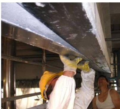
Posizionamento delle lamine di carbonio nell'intradosso della trave.
