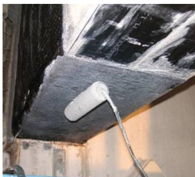
Posizionamento del tessuto in fibra di carbonio e stesa della resina epossidica per il successivo incollaggio.
