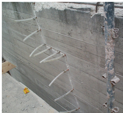
Fissaggio delle cannucce di iniezione.
