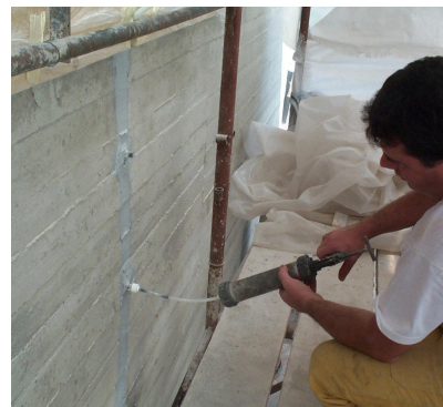
Iniezione della resina epossidica liquida per il consolidamento del muro.
