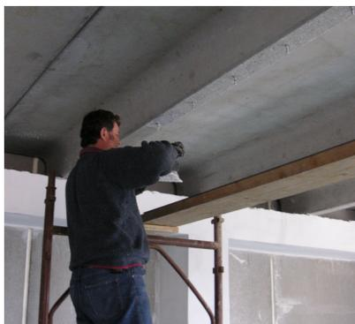
Stesa del collante strutturale epossidico per l'incollaggio della lamina in acciaio.
