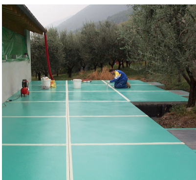
Messa in opera dell'impermeabilizzazione.
