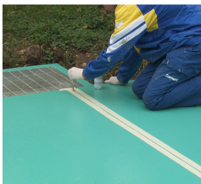
Particolare della stesura del Primer.
