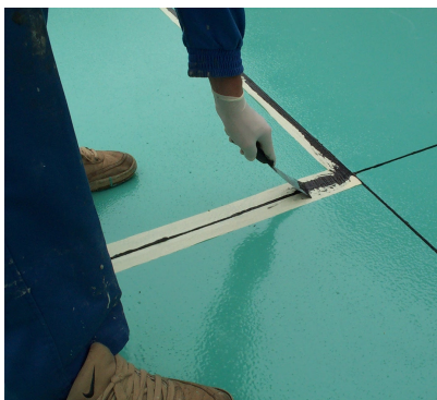
Regolarizzazione del sigillante all'interno del giunto.
