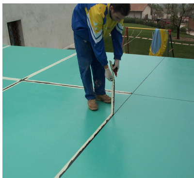
Fasi di pulizia.
