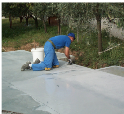
Stesura del Primer di aggrappo nei risvolti del muro verticale.
