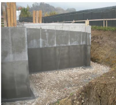
Impermeabilizzazione muro interrato con applicazione a spatola di malta cementizia.
