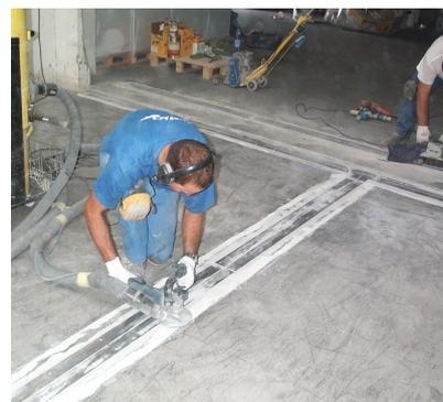
Livellamento del nuovo giunto con il pavimento esistente.
