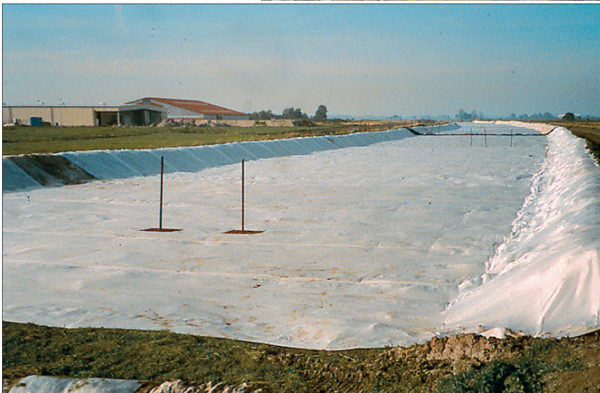
Rinforzo con Stabilenka® 300/45 sul rilevato della circonvallazione di Jever
