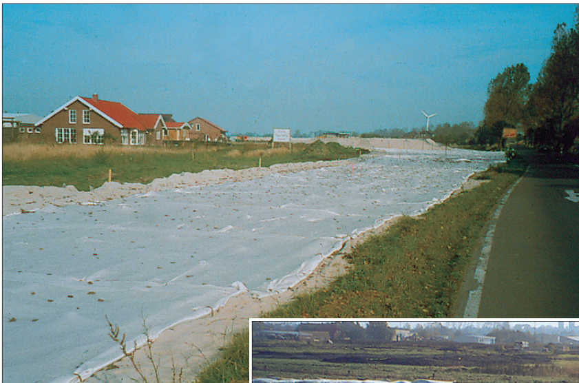
Base del rilevato rinforzata con Stabilenka® 150/45 ; rampa di accesso alla circonvallazione di Jever – Germania
