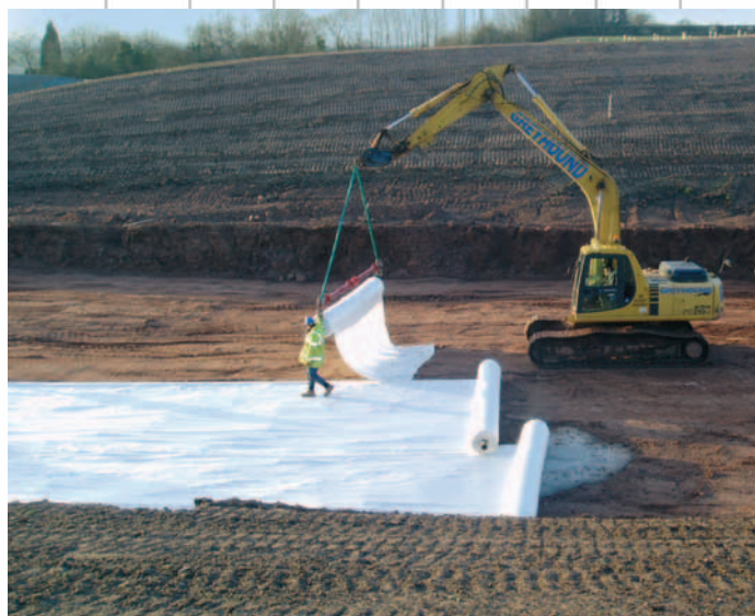
Attraversamento di cavità
