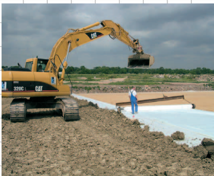
Copertura di un deposito di fanghi
