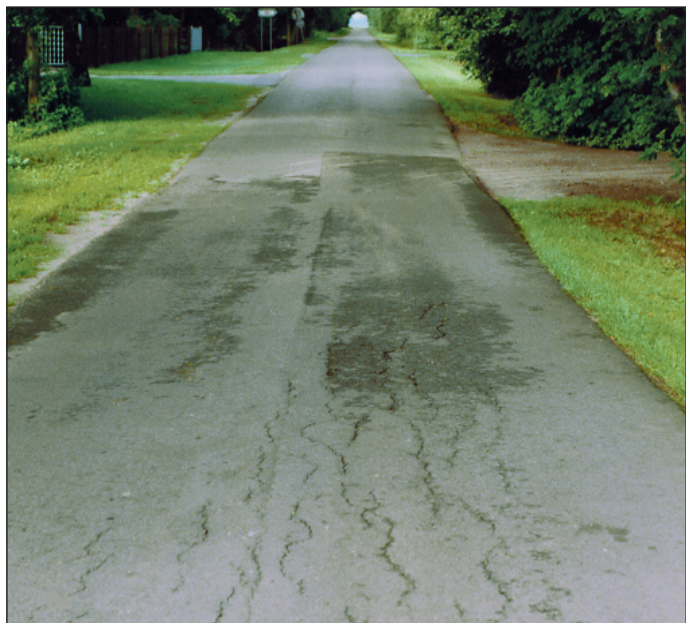
Stato originale della strada Scharreler Damm (Germania) nell'anno 1990, prima dei lavori di manutenzione effettuati impiegando la geogriglia HaTelit®
