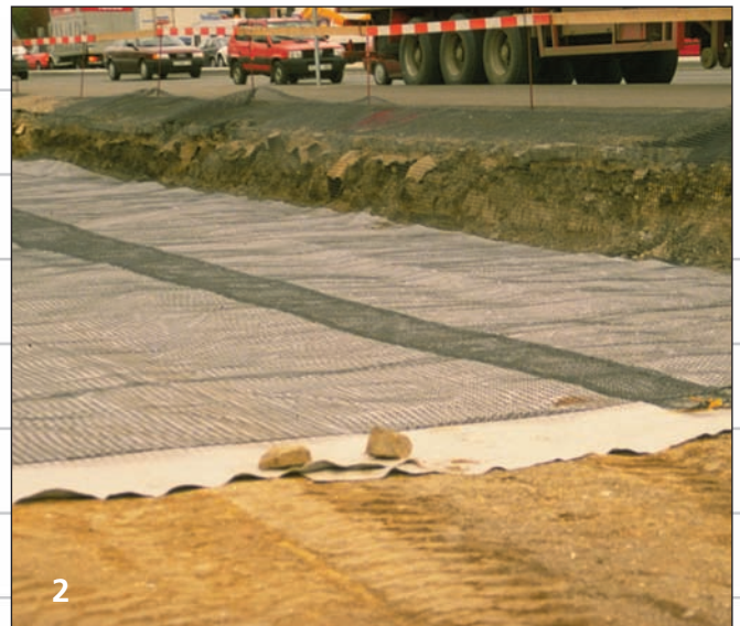
Foto 1 e 2: rinforzo delle fondazioni stradali con geogriglie Fornit®
