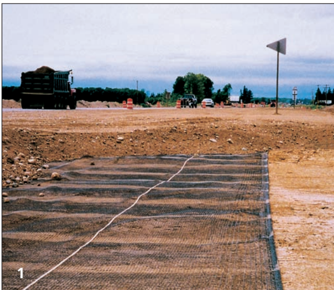
Foto 1 e 2: rinforzo delle fondazioni stradali con geogriglie Fornit®
